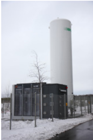
Strombegrenzer mit Vorratstank für flüssigen Stickstoff
