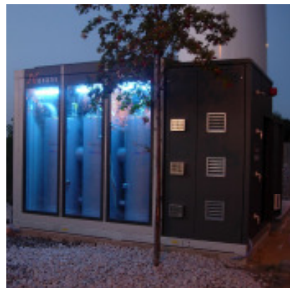
Strombegrenzer mit Vorratstank für flüssigen Stickstoff
