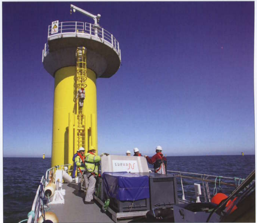
Mit solchen Schiffen – wie hier auf dem Bild zu sehen – werden die Seekabel verlegt und montiert. Foto: Nexans
