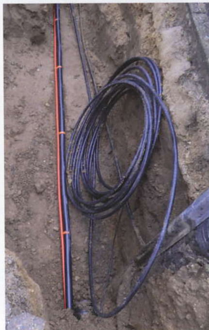
Verlegung des NS-Hybridkabels X-Linked in einem 250 m langen Rohrsystem.
