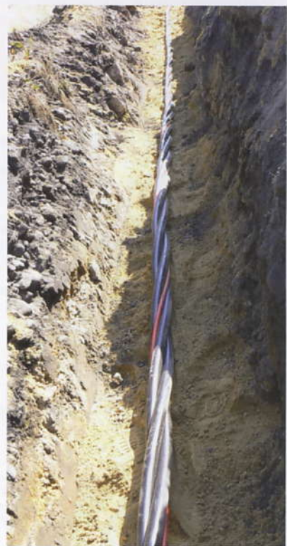
Mittelspannungs-Hybridkabel mit einem PE-Rohr.
