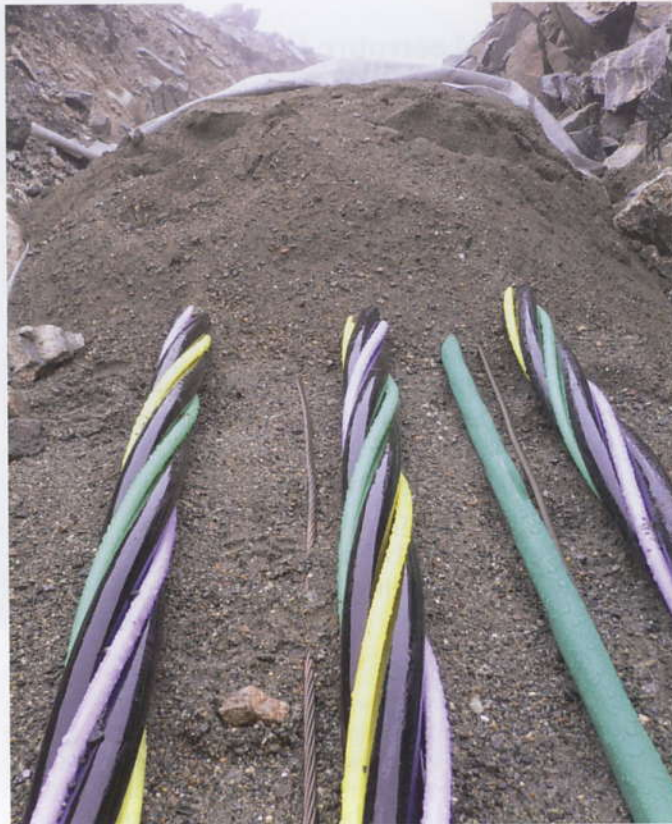
Offene Verlegung von drei Mittelspannungs-Hybridkabelsystemen.
