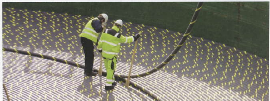
Abb. 3 Inmitten des großen Turn-Tables, aus dem das Kabel ins Wasser verlegt wird, ist auf die exakte Lage des Kabelstranges zu achten.
