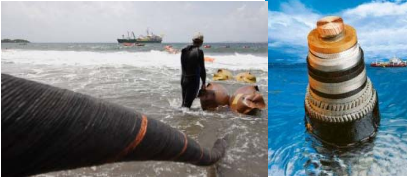
Verlegung des HGÜ-Kabels
