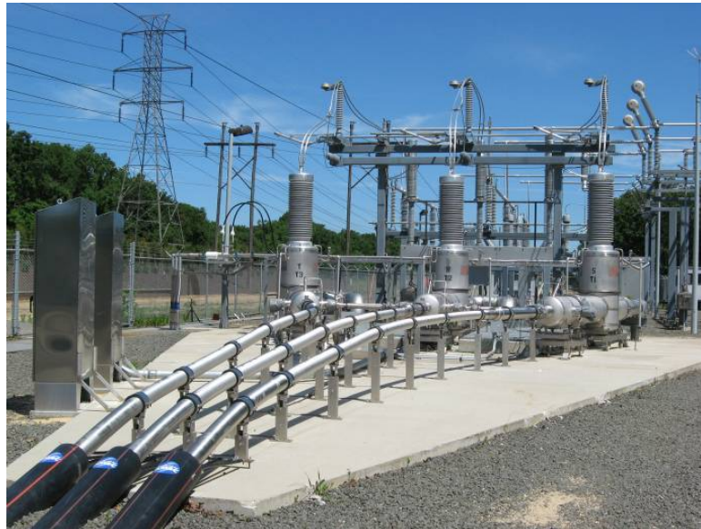
LIPA: weltweit erstes supraleitendes Hochspannungskabel
