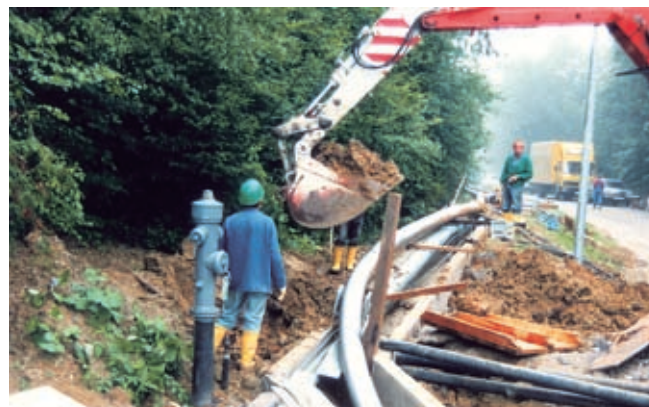
Verlegung einer langen Transferleitung (LOX) Laying of a long Transfer Line (LOX)
