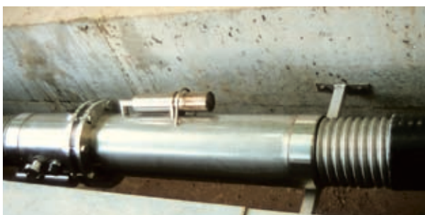
Kupplung einer CRYOFLEX®-Leitung im Schacht Coupling of a CRYOFLEX® Line in a ditch
