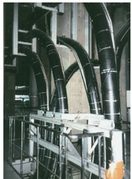
Supraleitendes LTS-Kabel für die Fusionsforschung in Japan (NIFS)
