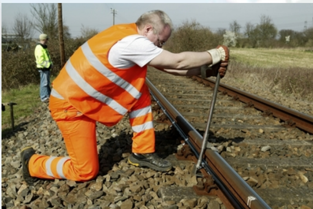
Spezielle Halteklammern geben den DuoTrack®-Kabeln diebstahlsicheren Sitz.
